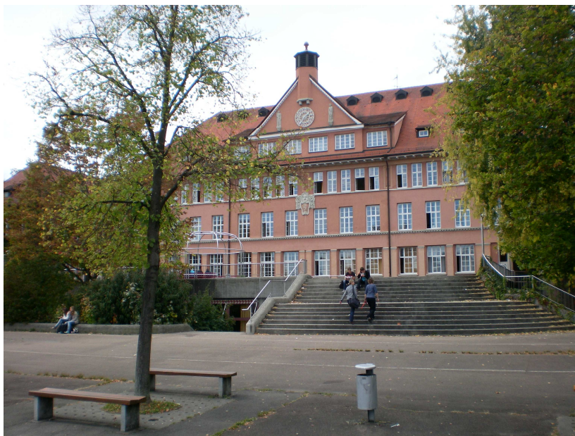
Abb. 1: Blick auf die Ostfassade des Schubart-Gymnasiums
